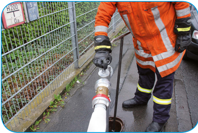
Eine 1000 Liter Pumpe wird bei Einsatz des Feuerwehr-KMR problemlos versorgt.
