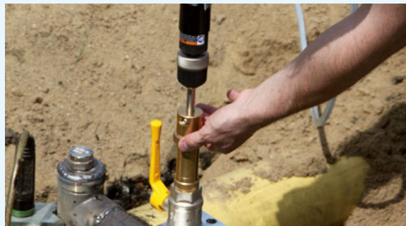
Anbohrung der Stahl-Gasleitung unter Druck.
